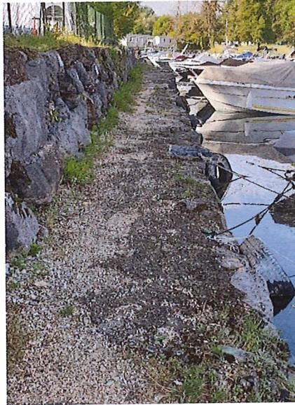
L'opération consiste à conforter les quais du camping dans le port du bras mort de la Leysse par l'installation de pieux bois de diamètre 300 mm de longueur 7,00 m fichés dans le sol à une profondeur d'environ 4,50m devant la rangée d'enrochement aval.
